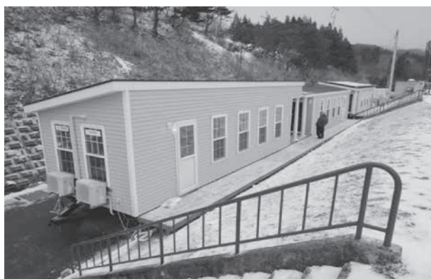
図-1 仮設住宅脇に設置されたトレーラーハウス
