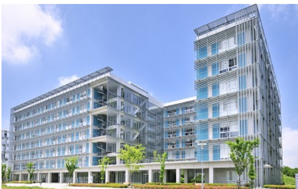
図 3 環境棟外観 Fig. 3 Exterior of Kankyoutou
