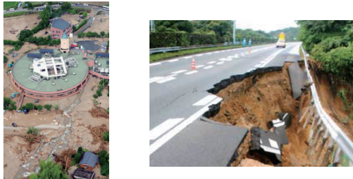
図 1 (左) 朝日新聞社 2009 年 7 月 21 日山口県土石流災害 (右):同社 2009 年 8 月 11 日東名道路崩落現場 Fig. 1 Disaster in Yamaguchi Pref at 21st July 2009 from asahi new paper(left), Slope failure in Tomei exp way at 11st August 2009 from asahi new paper(right)
