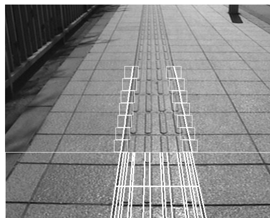
(d) タイル貼り歩道の点字ブロック
