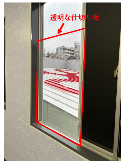
図 18 設置した透明な仕切り板
