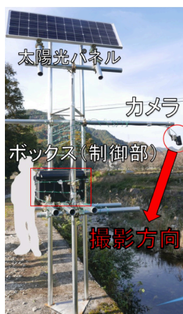
図 2: 土砂災害モニタリングシステムの外観
