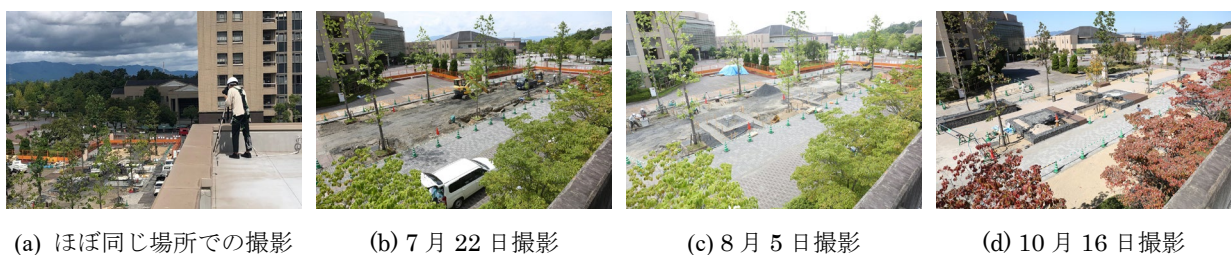
図6 屋上からの準定点観測による工事区間の俯瞰画像 Fig.6 Bird's-eye view image of the construction section by quasi-fixed point observation from the roof
