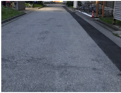
(a) 雪の積もっていないアスファルトの道路
