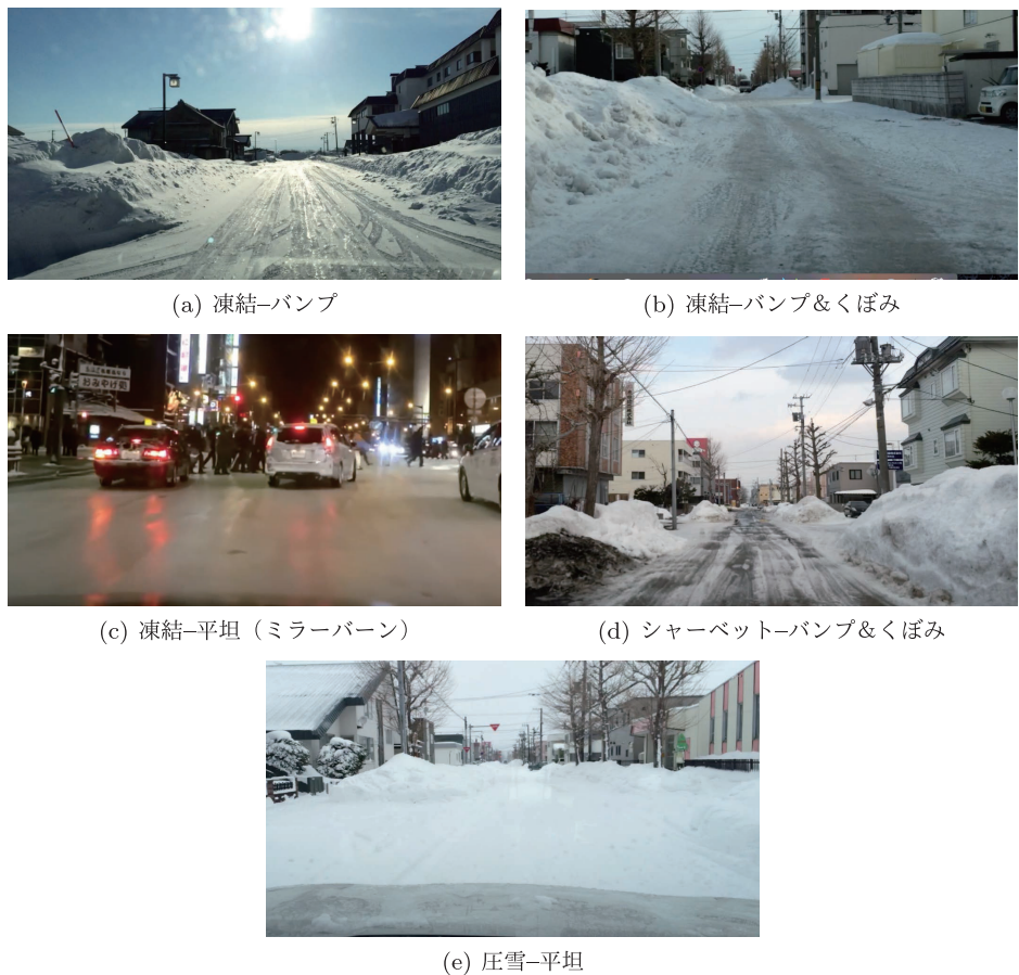
図 4 検知対象となる路面状況の例
