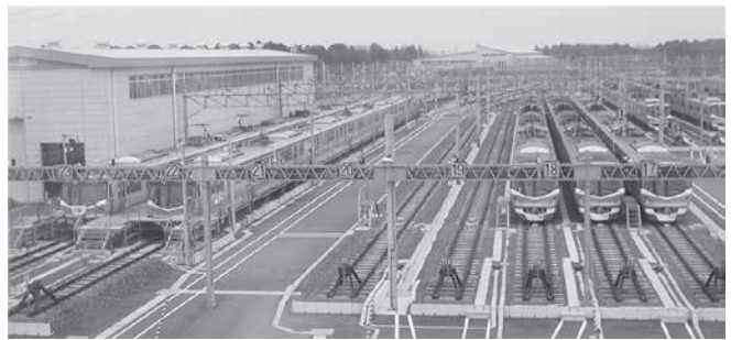
図-3 車両基地—検査や清掃を行う
