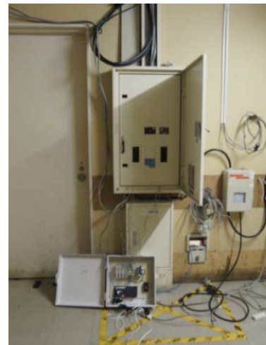
図 3 分電盤への機材の設置状況
