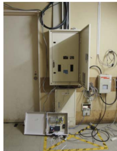
図 3 分電盤への機材の設置状況
