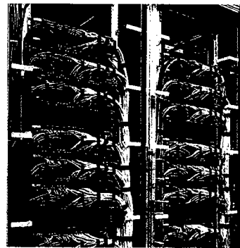
図-7 各教室へつながるTPケーブルを接続したスイッチ群
