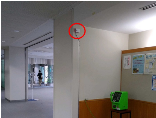
(b) 設置の様子（KUDOS 棟）
