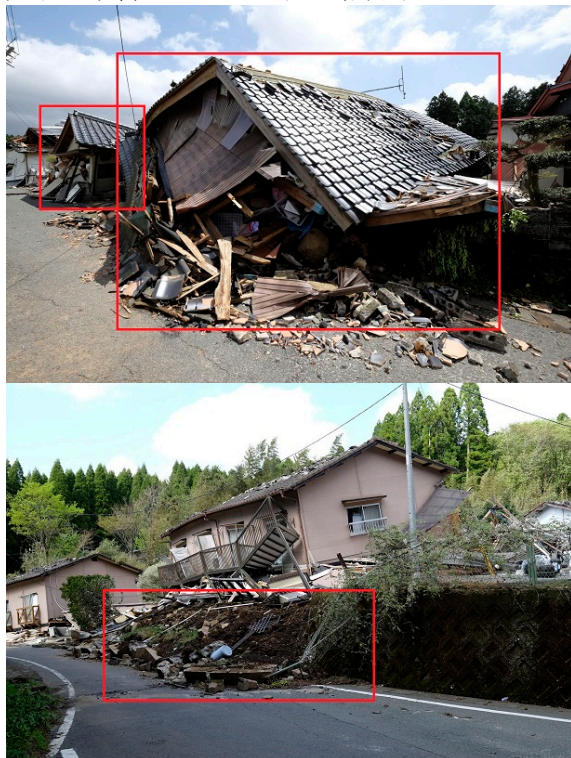
図1. 「家屋倒壊」(上)と「土台崩れ」(下)
