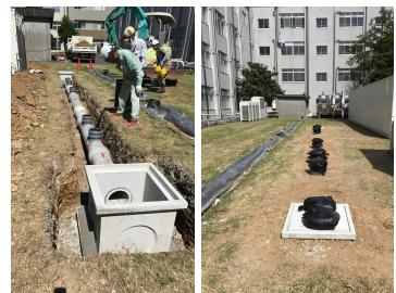
図 1 実験用ヒューム管: (左) 設置工事の様子、(右) 完成後
