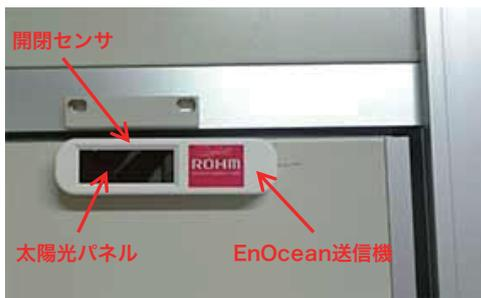
図 3 エナジハーベストドア開閉センサ
