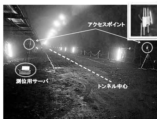
図4: トンネル施工現場の実験状況
