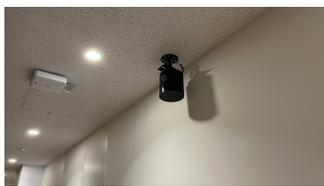
図 13 LiDAR の設置方法
