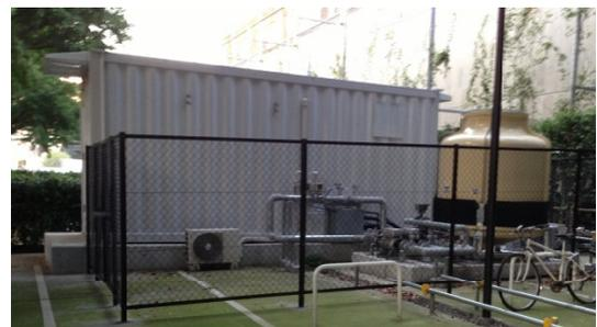
図 3 TSUBAME-KFC の外観。20 フィートコンテナの隣に冷却塔が設置されている
