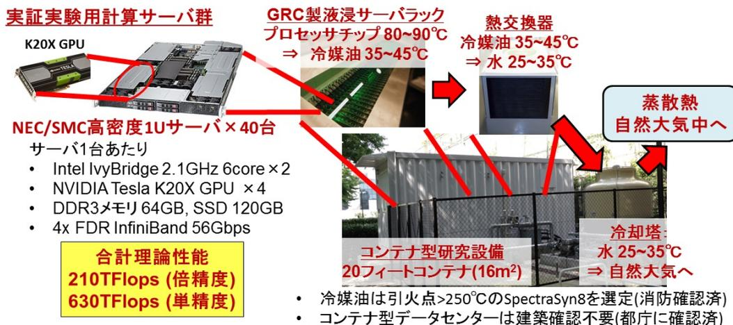
図 1 TSUBAME-KFC の冷却方式の概要. 計算サーバが発した熱は, 冷媒油から水へ, そして自然大気中へ放出される.
