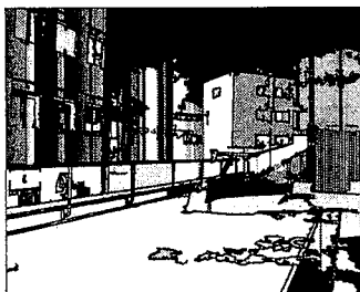
図 11 距離画像結果 (シミュレーション例 1) Fig. 11 Distance image result (Simulation example 1)
