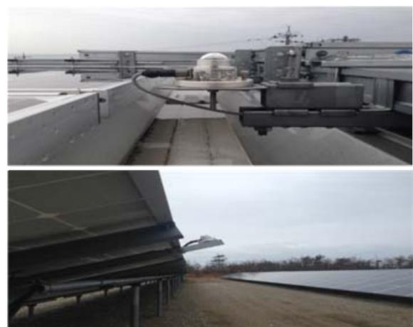
図1 日射計取り付け状態
