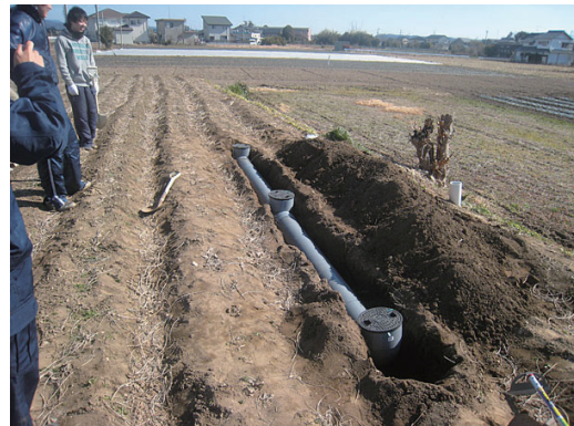
図 12 土中の VU 管における実験風景：VU 管の設置
