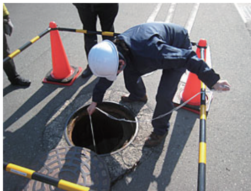
図 9 下水道管きよにおける実験風景：端末の配置作業
