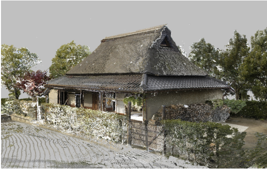
図7 図6の古民家のレーザ計測データ ( 2.95 \times 10^7 点)
