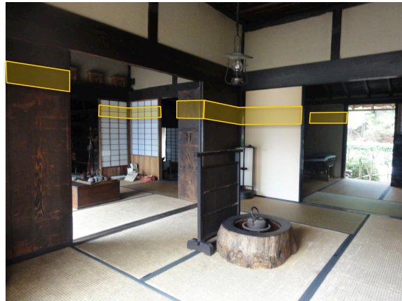
図9 断面図作成のための点群取得範囲
