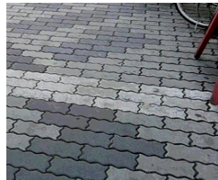
図 8 タイルの歩道 Fig. 8 Tiled sidewalk.
