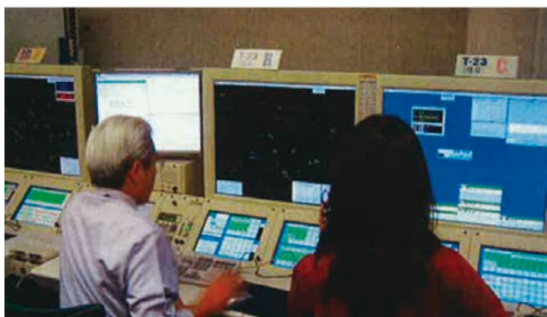
図-7 管制区管制所 5)
