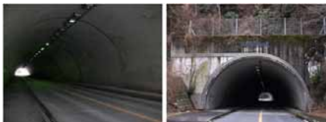
図8 電波ブラインド領域として選んだトンネル Figure 8 Tunnel as the blind zone of electric wave.
