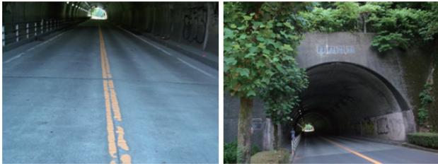
図 8 電波ブラインド領域として選んだトンネル Fig. 8 Tunnel as the blind zone of electric wave.
