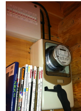
図1 世帯におけるスマートメータの設置例
