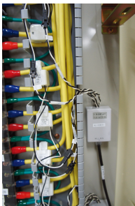
図 6 電流センサ
