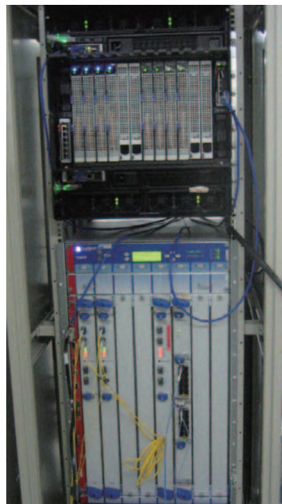
写真2 さっぽろ雪まつりで使用した JCS 1200 と T1600 概観 (東京大手町) (ラック上部: JCS 1200, 下部: T1600)
