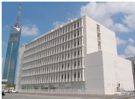
図-3 福岡システムLSI総合開発センター (九州大学連携型起業家育成施設)
