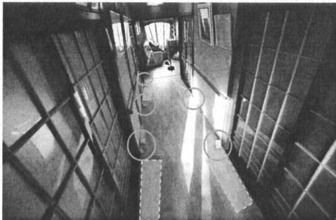
図 5 廊下へのアンテナ設置 (RFID リーダ装置の壁面への取付け前)
