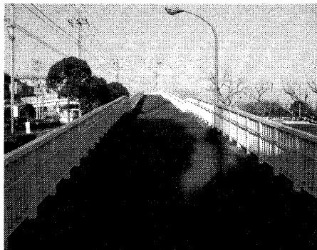
図10: 測定場所(歩道橋)
