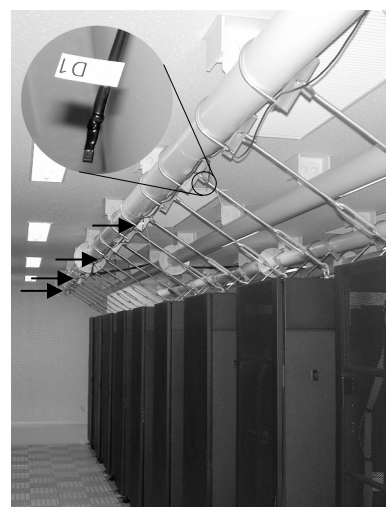
図 4 温度センサの取付け
