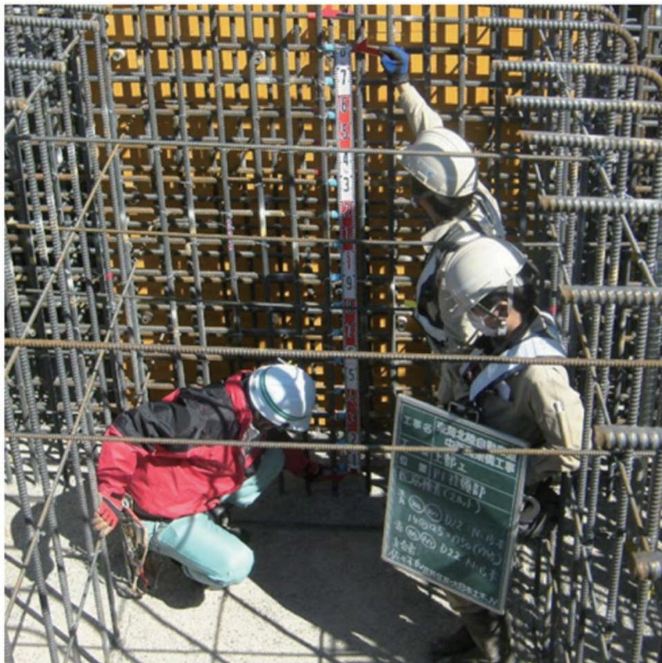
図1 鉄筋出来形計測の立会検査の状況
