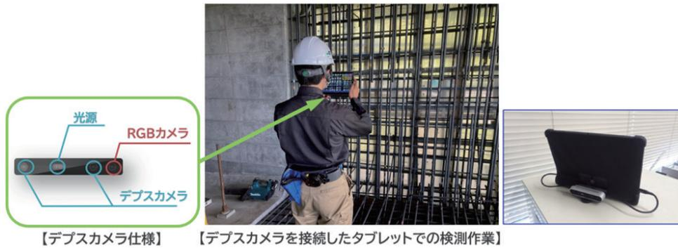
図2 鉄筋出来形自動検測システムの概要
