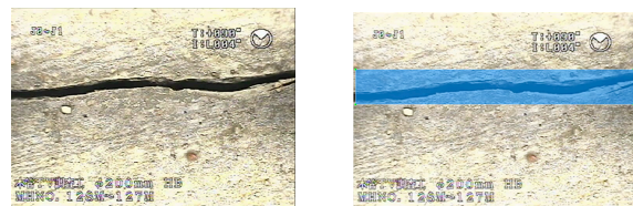
図 2: 下水道管の元画像 図 3: labeling 加工画像
