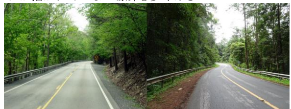
図 2 レーンマークの状況
