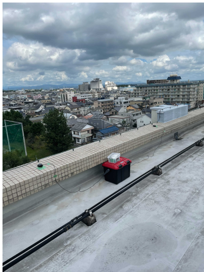
図 12 大学屋上に設置した観測機材
