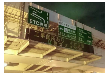
図 4 道路上に設置された VMS
