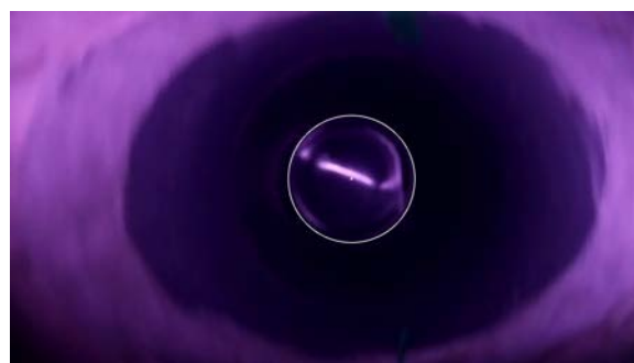
図 8 図 7 の映像フレームにてハンドホールを検出した様子
