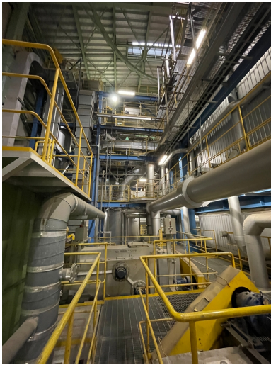
図 1 清掃工場，炉室内
