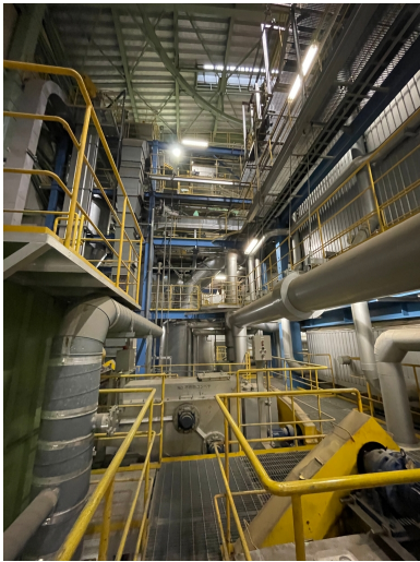
図 1 清掃工場，炉室内 Fig. 1 Overview of an incineration.
