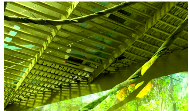
図 4 天井に設置したセンサ (格子の箱内)
