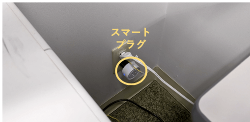
(c) 設置したスマートプラグ
