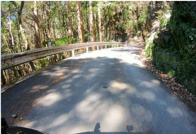
(a) 道路の状況
