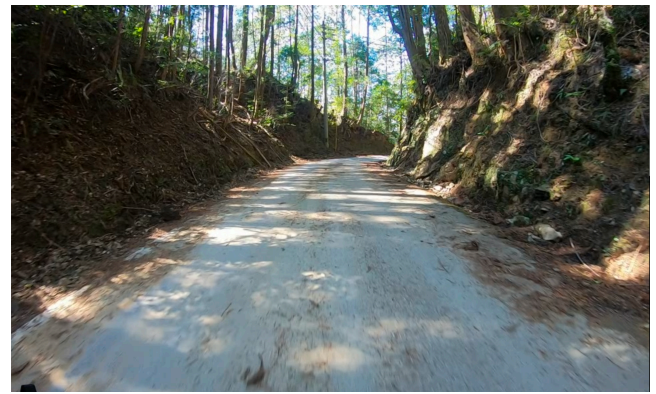
(a) 道路の状況
