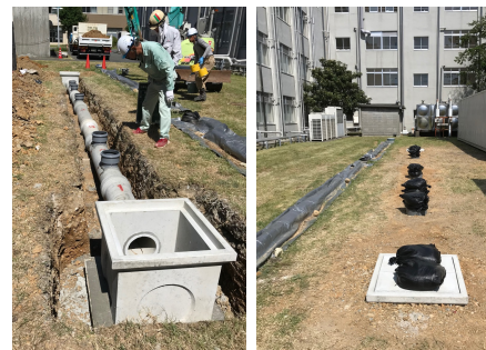
図 2: 実験用 φ250mm ヒューム管
