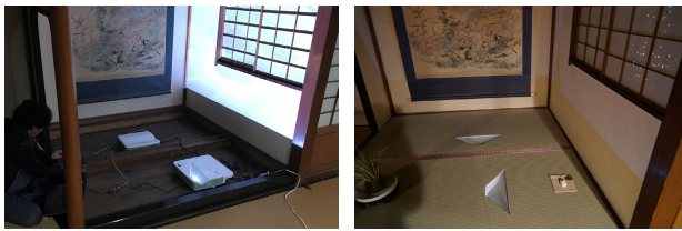
(a) 床の間の畳の下に設置した超短焦点プロジェクタ (b) 穴の開いた特注の畳短焦点プロジェクタ
