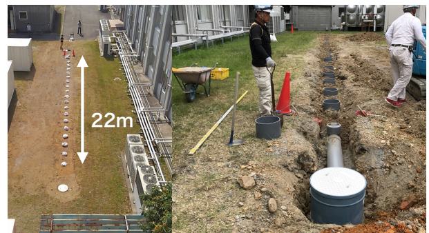
図 4 学内に設置した実験用模擬下水管
