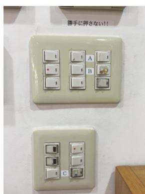
図 1 目的と異なる照明を ON/OFF してしまうスイッチ
